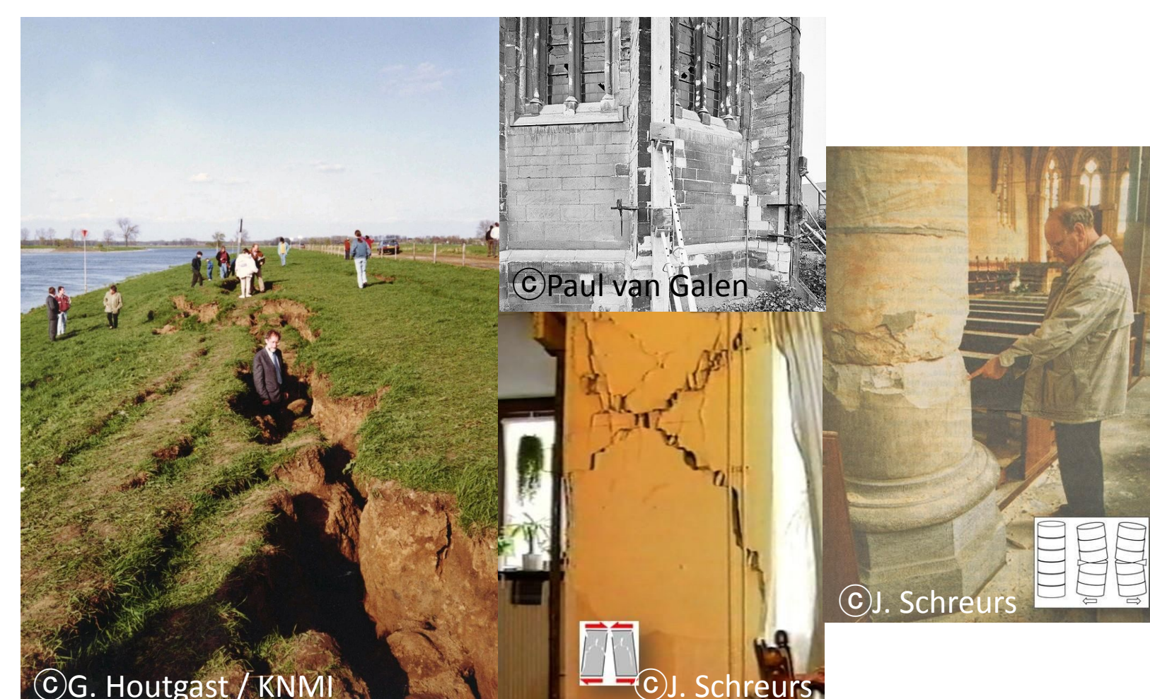
Dégâts à l'église Herkenbosch à Roermond (NL). En Belgique, il y a eu des dégâts à Maastricht Schade aan de Herkenboschkerk te Roermond (NL). In België was er schade in Maastricht
